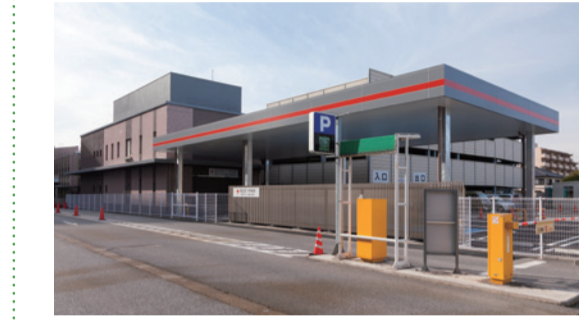
専用の設備と高度な人材育成により、原子力災害に備える
